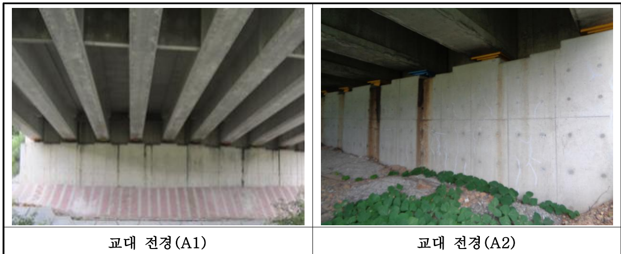
【사진 20.3.33】 교대 전경
