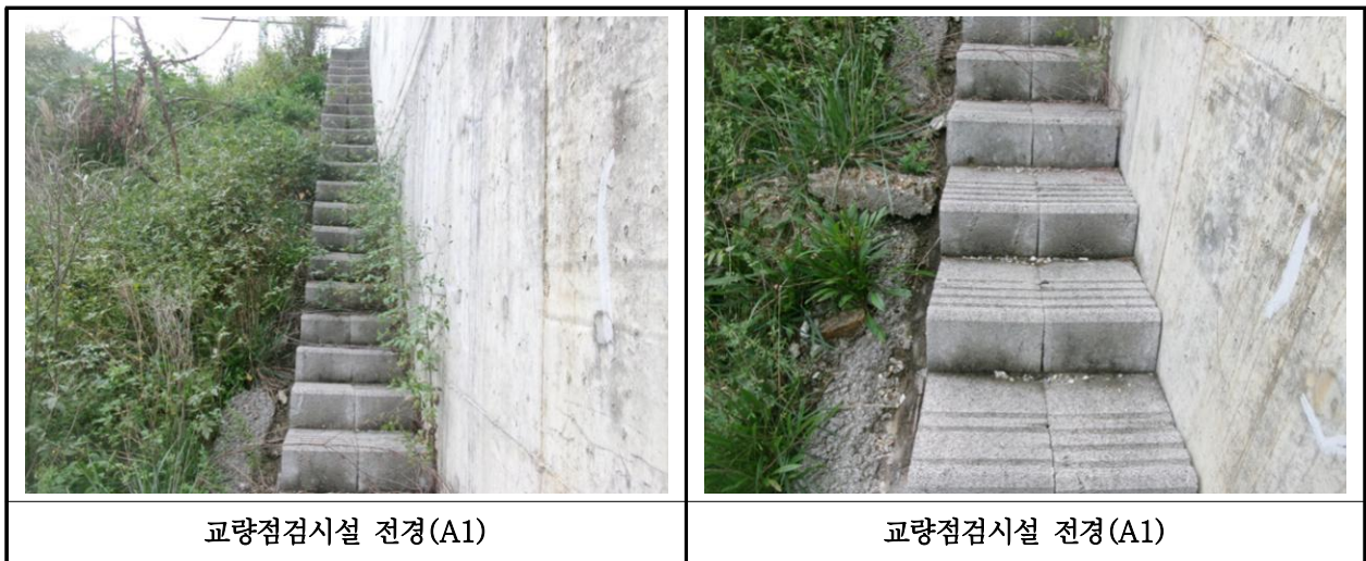
【사진 20.3.50】 교량 점검시설 전경
