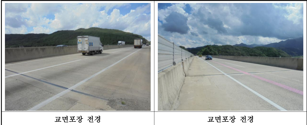
【사진 20.3.19】 교면포장 전경
