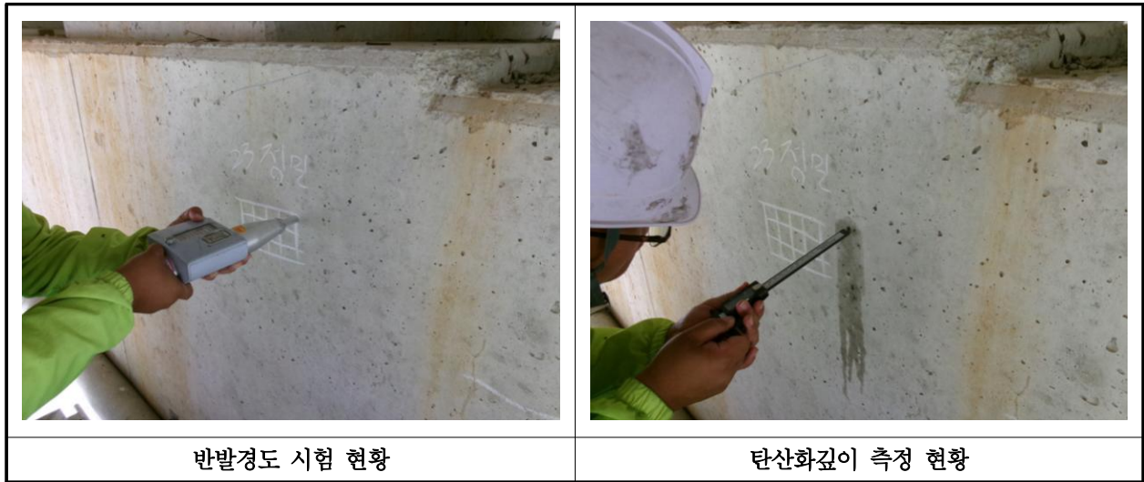
【사진 20.4.1】 콘크리트 내구성조사 현황
