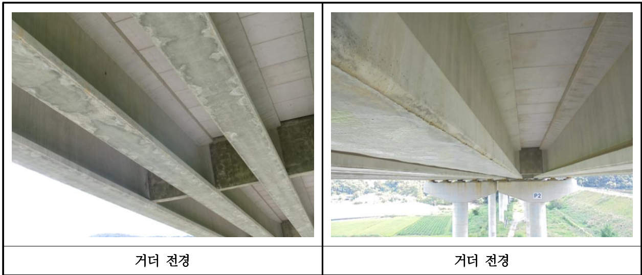
【사진 20.3.29】 거더 전경
