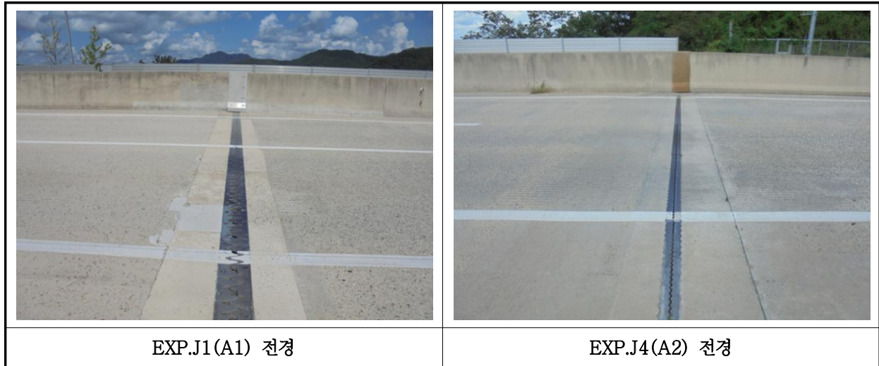
【사진 20.3.41】 신축이음장치 전경
