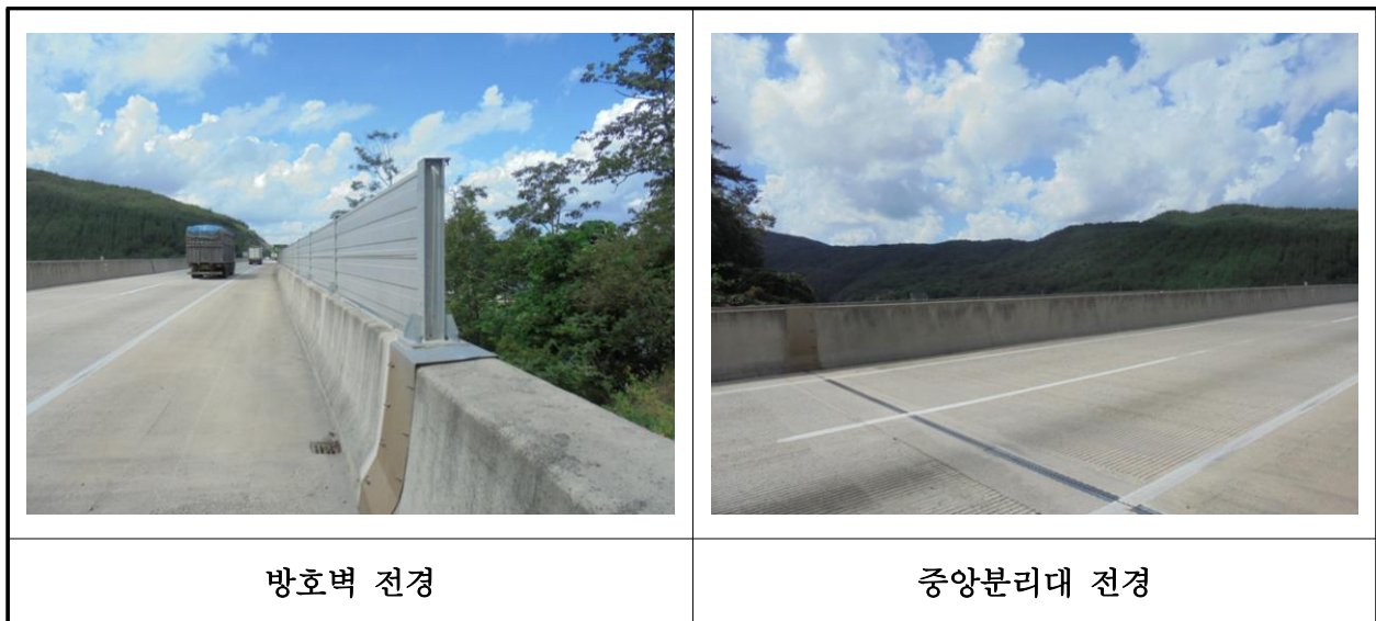
【사진 20.3.23】 방호벽 및 중앙분리대 전경
