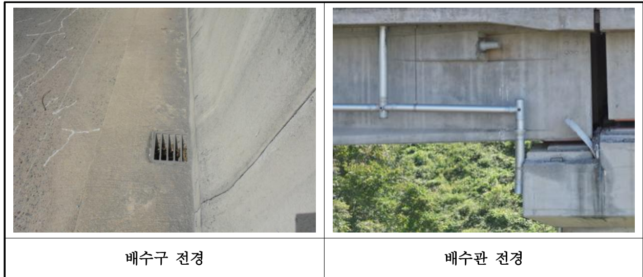
【사진 20.3.21】 배수시설 전경
