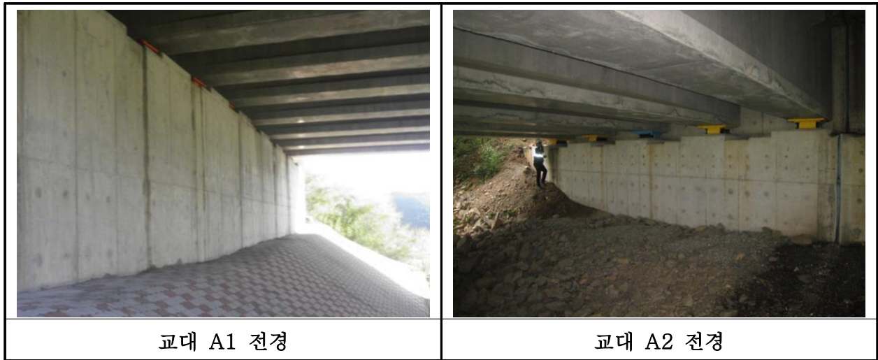
【사진 20.3.8】 교대 전경
