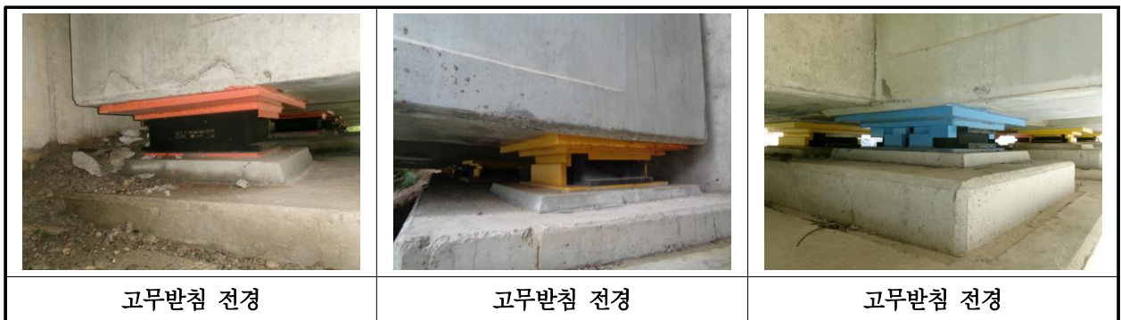
【사진 20.3.37】 교량반침 전경
