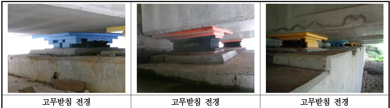
【사진 20.3.12】 교량반침 전경
