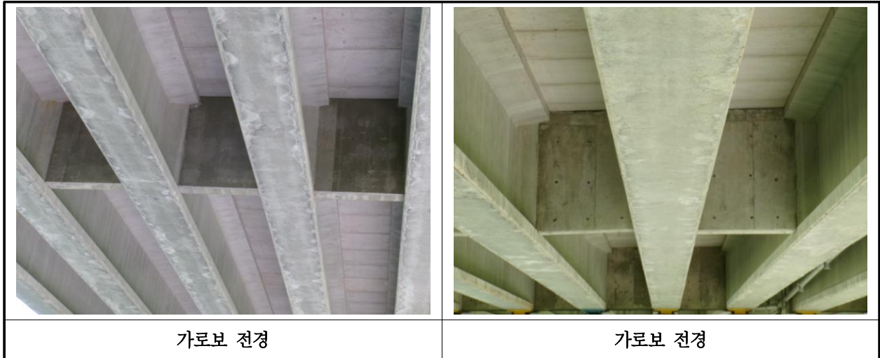
【사진 20.3.6】 가로보 전경
