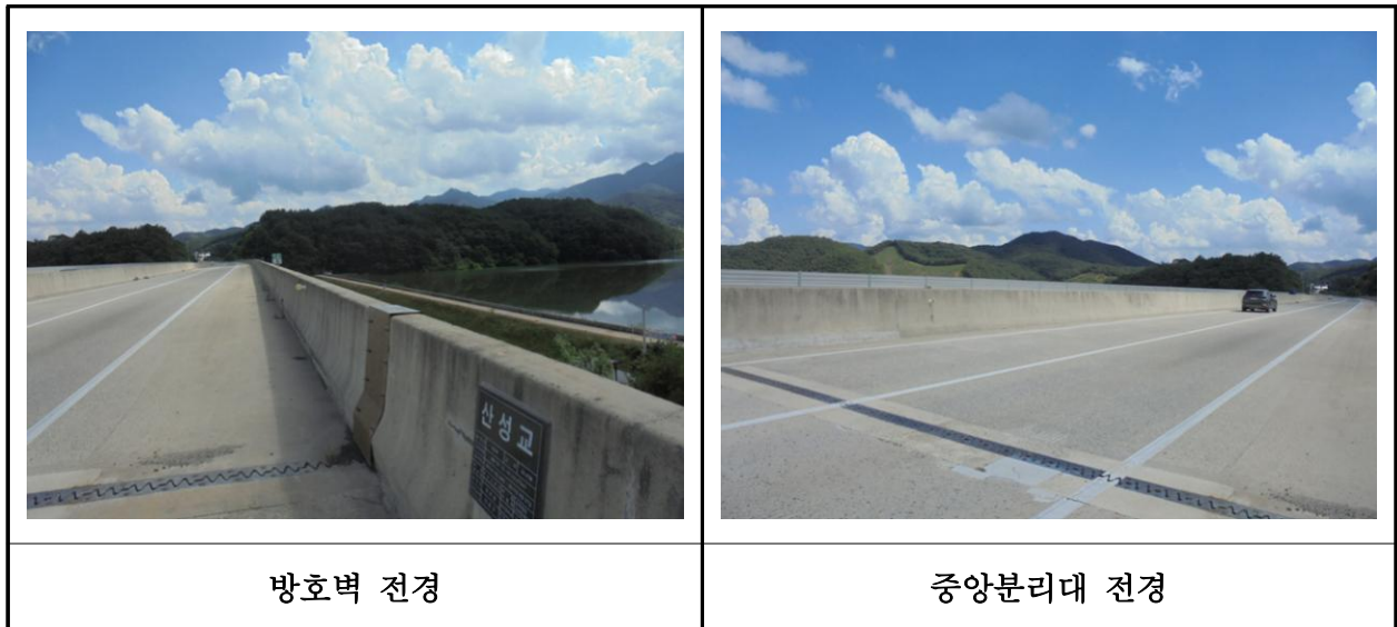
【사진 20.3.48】 방호벽 및 중앙분리대 전경
