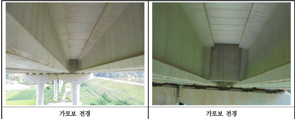
【사진 20.3.31】 가로보 전경
