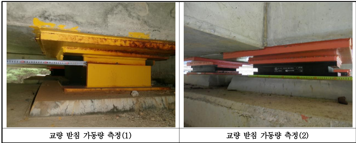
【사진 20.3.40】 교량받침 이동량 측정
